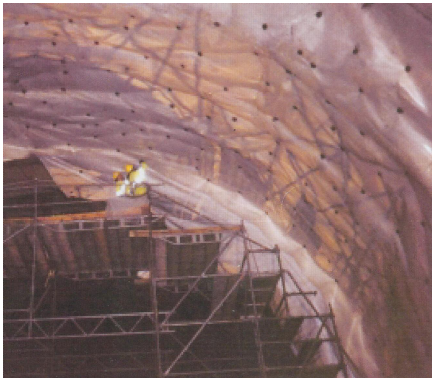
Рис.34. Устройство гидроизоляции в тоннеле из полимерной мембраны
