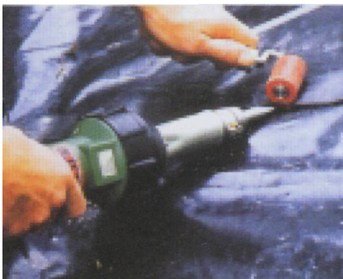
Рис. 35. Сварка полимерных листов гидроизоляции
