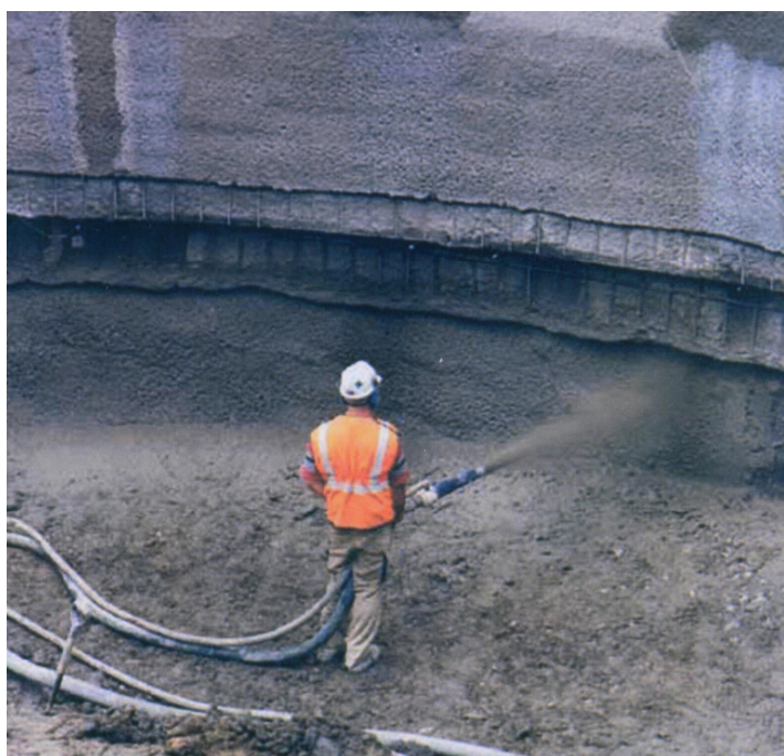
Рис.36. Устройство гидроизоляции методом торкретирования
