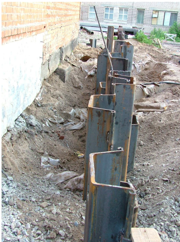
Рис. 12. Ограждающая металлическая шпунтовая стенка
