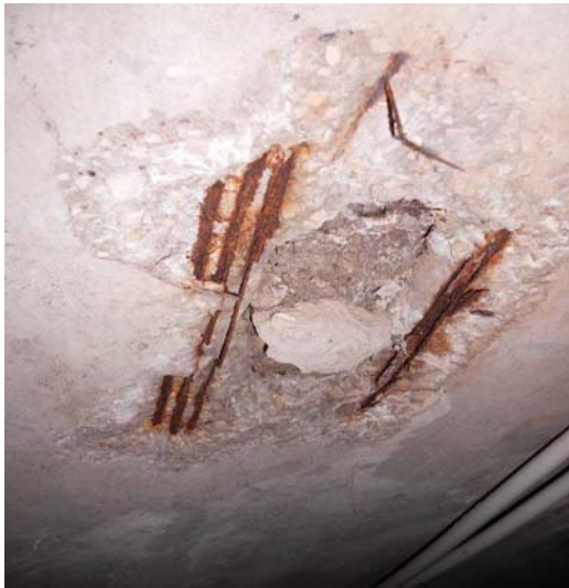
Рисунок 47 – Коррозия рабочей арматуры на 100 % сечения и сквозные отверстия в перекрытии
