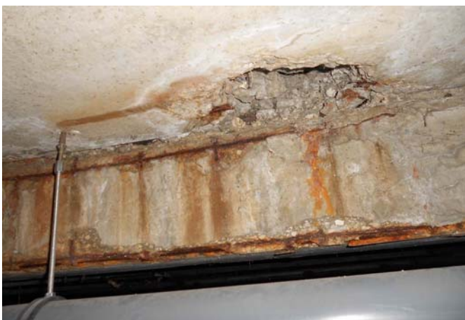
Рисунок 46 – Дефекты и повреждения ригеля
