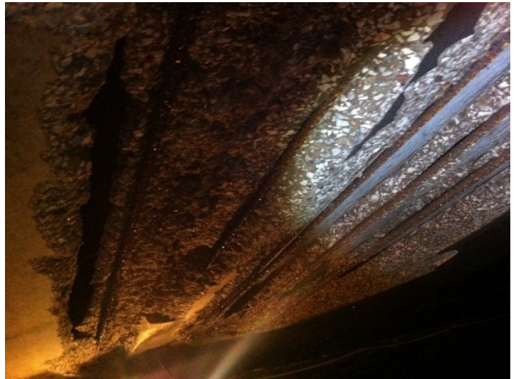
Рисунок 47 – Коррозия рабочей арматуры на 100 % сечения и сквозные отверстия в перекрытии
