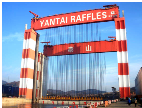
Рис. 2. Наибольший в мире кран «Тайсунь» китайского судостроительного завода Yantai Raffles грузоподъемностью 20 тыс. т. Высота подъема 70 м
