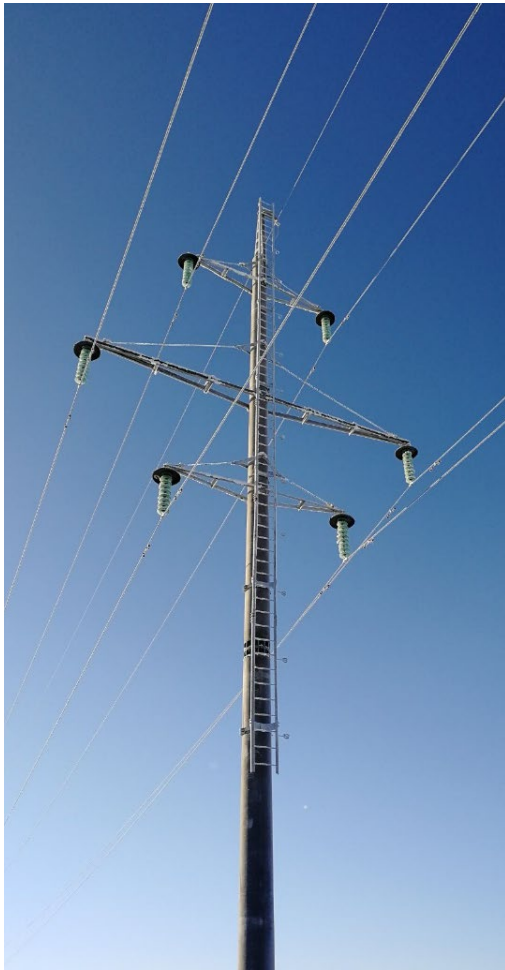
Рисунок 5.3 – Железобетонные опоры ВЛ нового поколения с использованием высокопрочного модифицированного бетона
