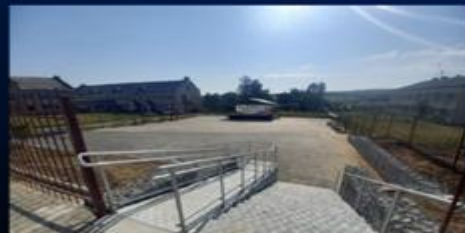
Благоустройство площади с. Осиновая Речка
