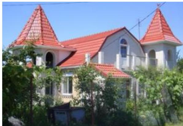
Рисунок 1.12 – Примеры кровли из цементно-песчаной черепицы производства концерна «Braas» (Германия) (по данным [32])
