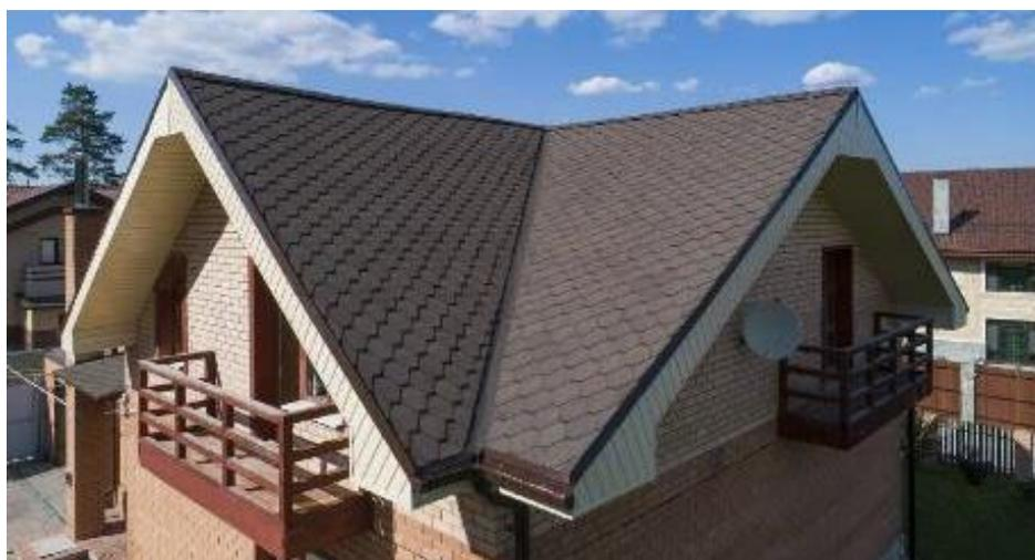
Рисунок 1.5 – Кровля из битумной черепицы
