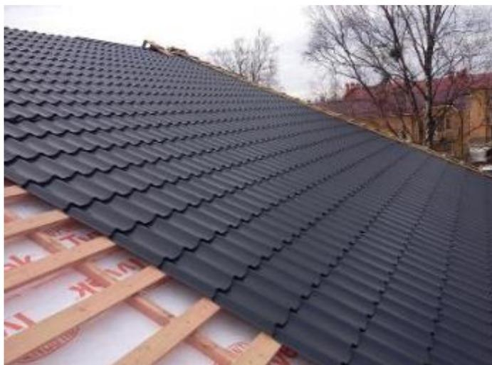
Рисунок 1.2 – Фрагмент кровли из листов металлочерепицы
