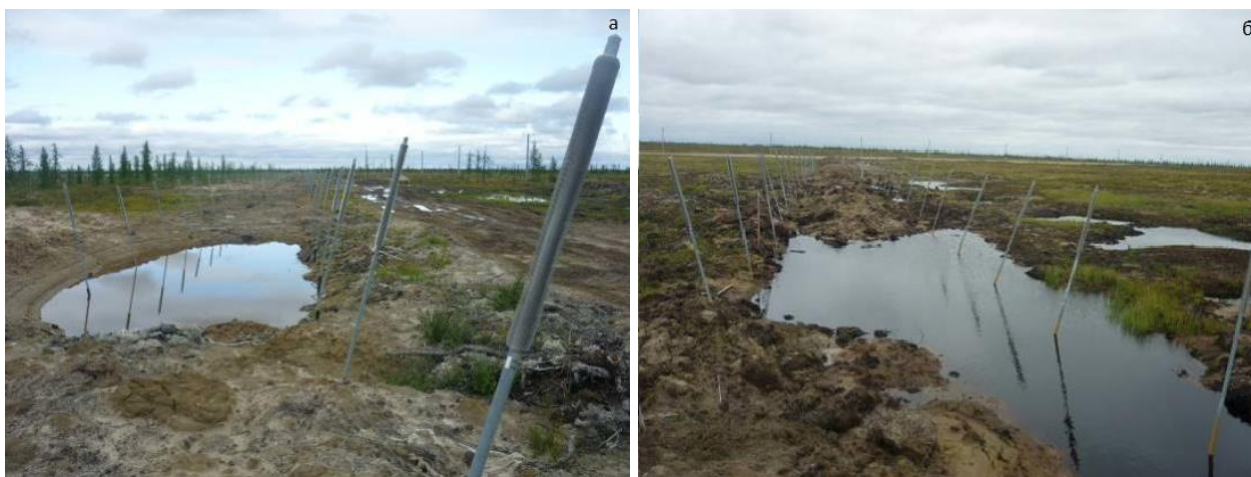
Рисунок 2.26 – Визуальное обследование верификационного участка трубопровода
