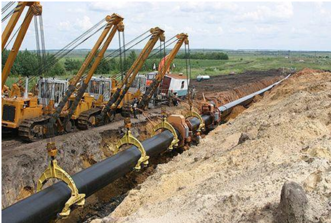
Рисунок 1.1 – Подземная прокладка трубопровода
