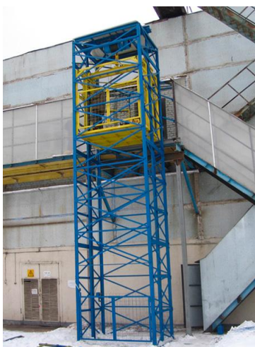
Рис. 94. Примеры установки подъемников
