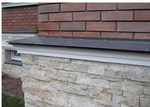
Рис. 29. Пример выступающего цоколя
