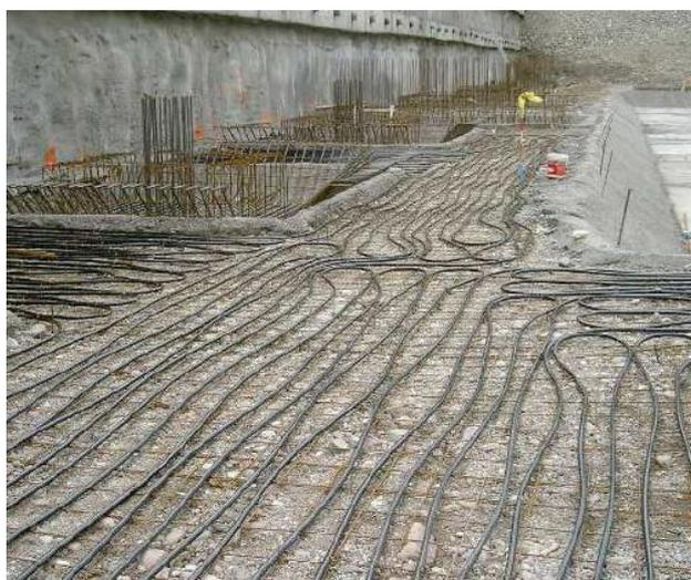
Рис. 14. Раскладка теплообменников перед бетонированием фундаментной плиты
