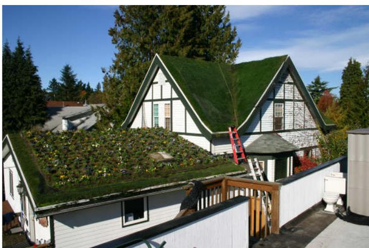
Рис. 43. Пример устройства зеленой крыши
