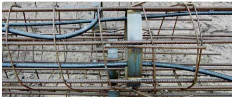
Рис. 10. Арматурные каркасы для буронабивных свай со смонтированными контурами теплообменников
