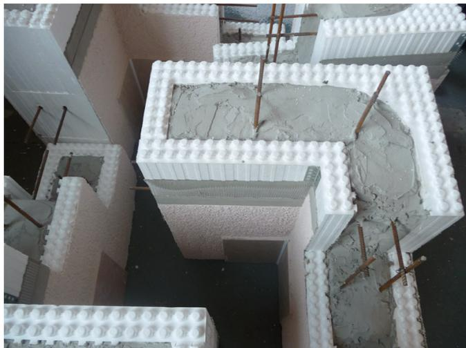
Рис. 40. Пример бетонирования в несъемной опалубке
