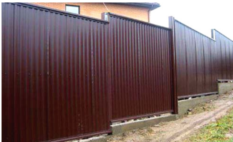
Рис. 45. Пример устройства ограды с доборными цоколями
