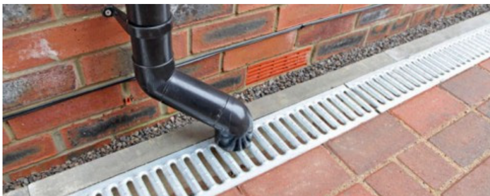
Рис. 66. Линейный ливневый дренаж. Водоотвод открытого типа
