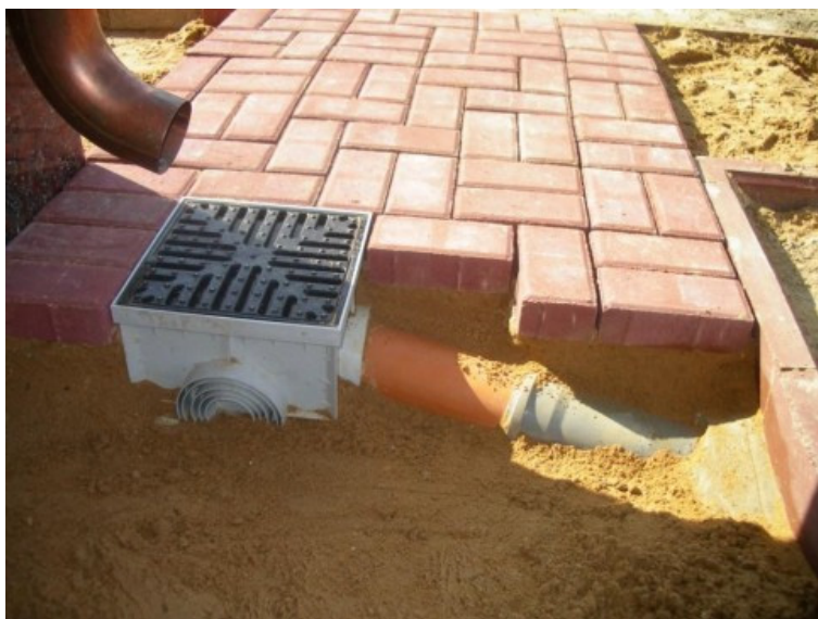
Рис. 65. Точечный ливневый дренаж
