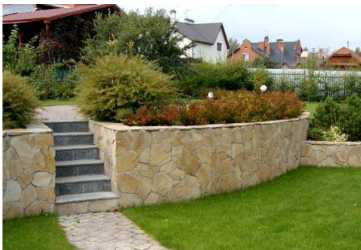
Рис. 70. Бетонная подпорная стенка с лестницей
