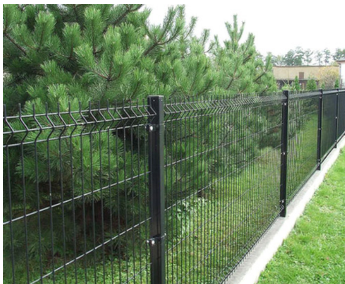
Рис. 43. Пример ограды из стальной сетки
