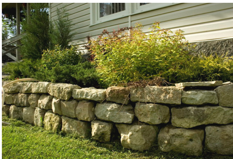
Рис. 74. Подпорная стенка, выполненная методом сухой кладки
