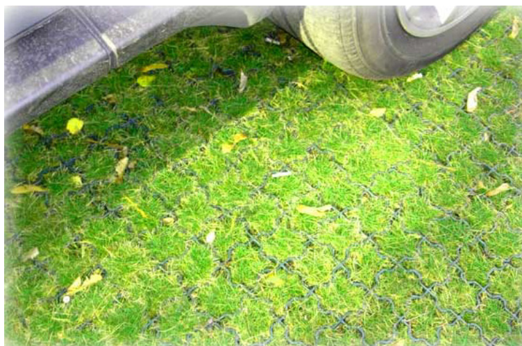
Рис. 37. Пример укрепления парковочного места при помощи георешетки
