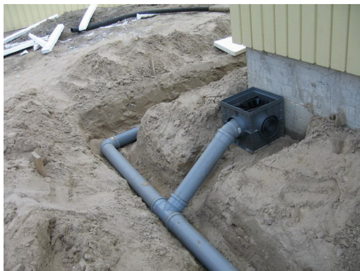
Рис. 67. Линейный ливневый дренаж. Водоотвод закрытого типа
