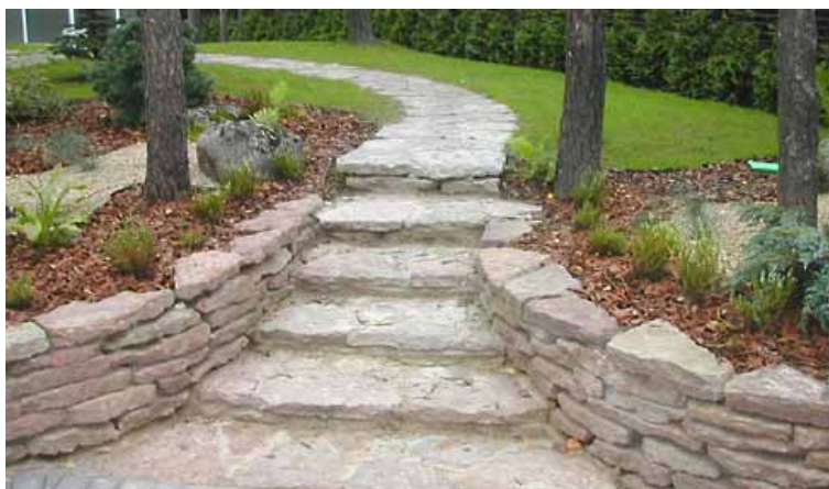
Рис. 79. Лестница на раствор
