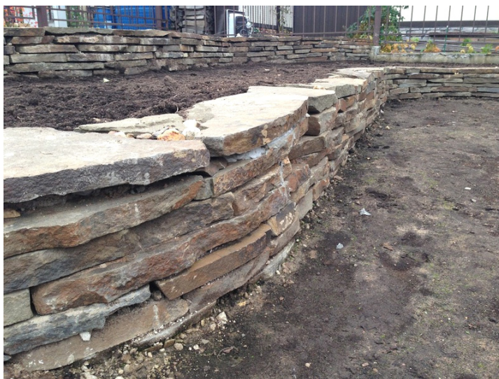
Рис. 76. Подпорная стенка из плитняка
