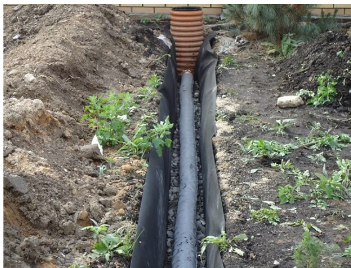
Рис. 68. Траншейный трубчатый дренаж
