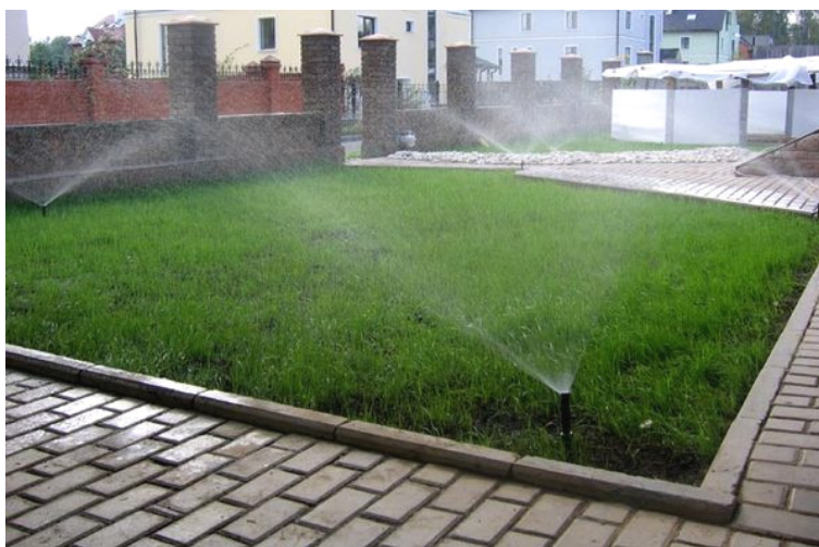
Рис. 85. Пример работы дождевальной системы автополива
