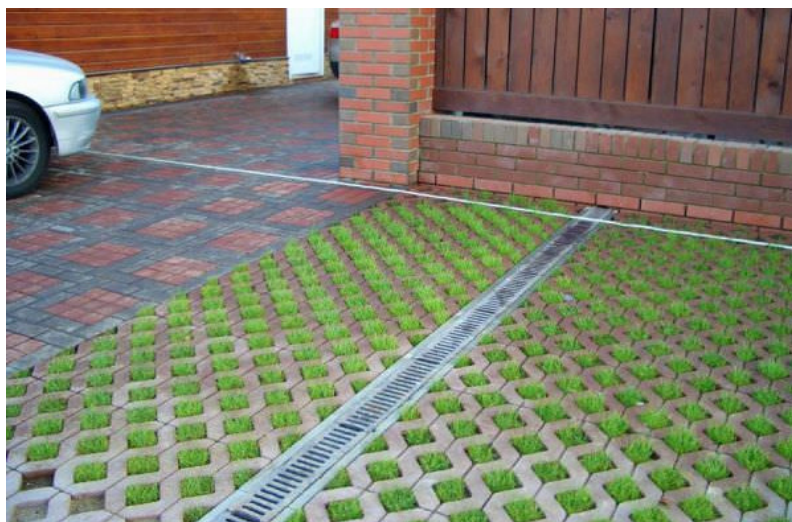
Рис. 16. Пример применения газонной решетки для покрытия парковочного места
