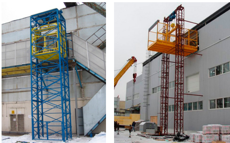
Рис. 14.1. Примеры установки подъемников
