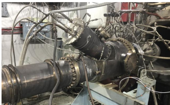
Рисунок 3 – Одномодульная МЭК в составе одногорелочного отсека
