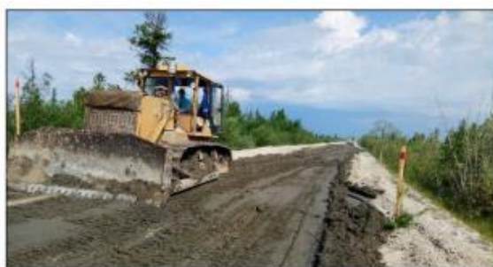
Распределение и планировка подготовленного бурового шлама. Подготовленный шлам разрабатывался в шламонакопителе экскаватором с погрузкой в автосамосвалы, в которых он транспортировался к участку строительства. Выгрузка осуществлялась в вал по оси будущего слоя. После чего проводилось распределение бурового шлама слоем 10-15 см бульдозерами и автогрейдерами. Отсыпанный слой проектной толщины разравнивался с учетом продольного уклона поверхности. В поперечном сечении поверхность слоя планировалась под проектный профиль. Фотографии процесса распределения и планировки бурового шлама представлены на рисунке 2.5.
