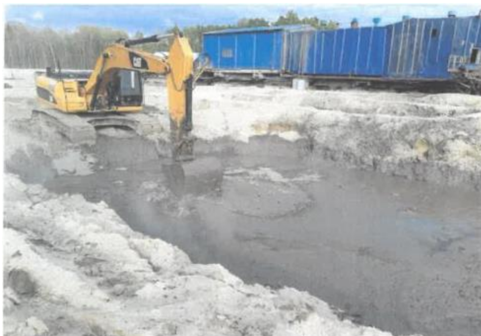
Рис. 2.14 - Подготовка шлама бурового на кустовой площадке
