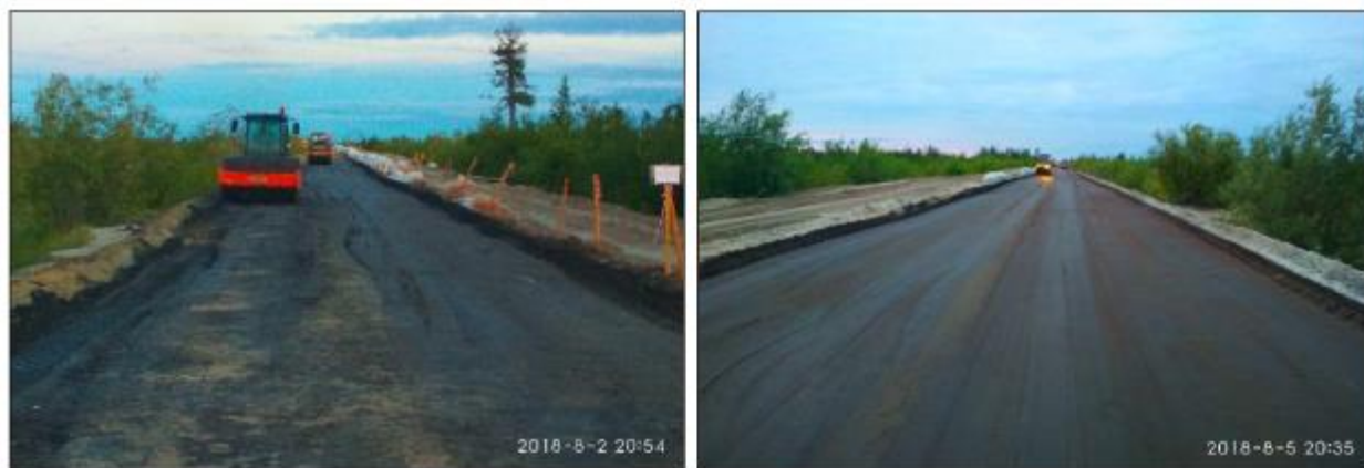
Рисунок 2.11 – Окончательное уплотнение слоя из строительного грунта «БРИТ»
