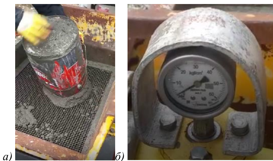
Рисунок 5.9 – Элементы технологии торкрет-бетонирования: а) предварительный просев на сите с ячейкой 5 мм; б) манометр с рабочим давлением 2,5 кгс/см 2 (0,25 МПа)
