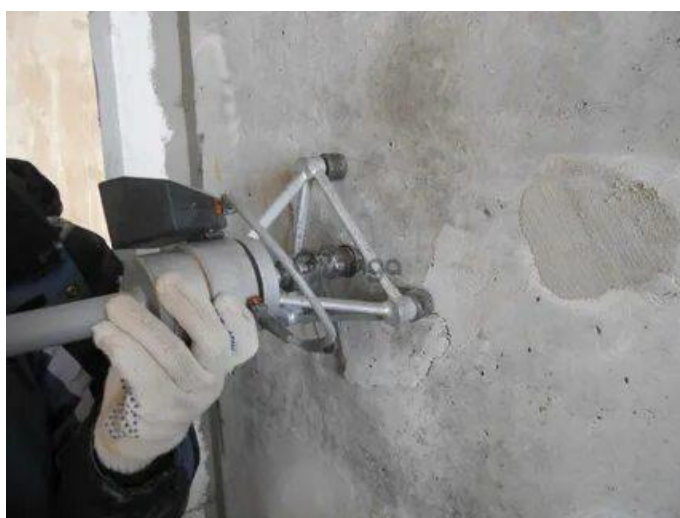
Рисунок 2.23 – Испытание бетона отрывом со скалыванием
