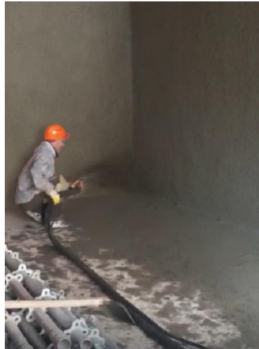
Рисунок 4.11 - Усиление несущей стены подземного перехода торкрет-бетоном
