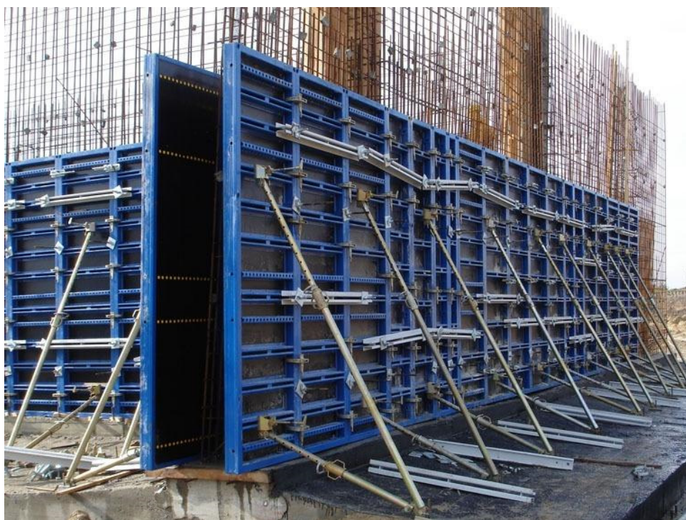
Рис. 1.13. Внешний вид вертикальной опалубки, закрепленной с помощью раскосов
