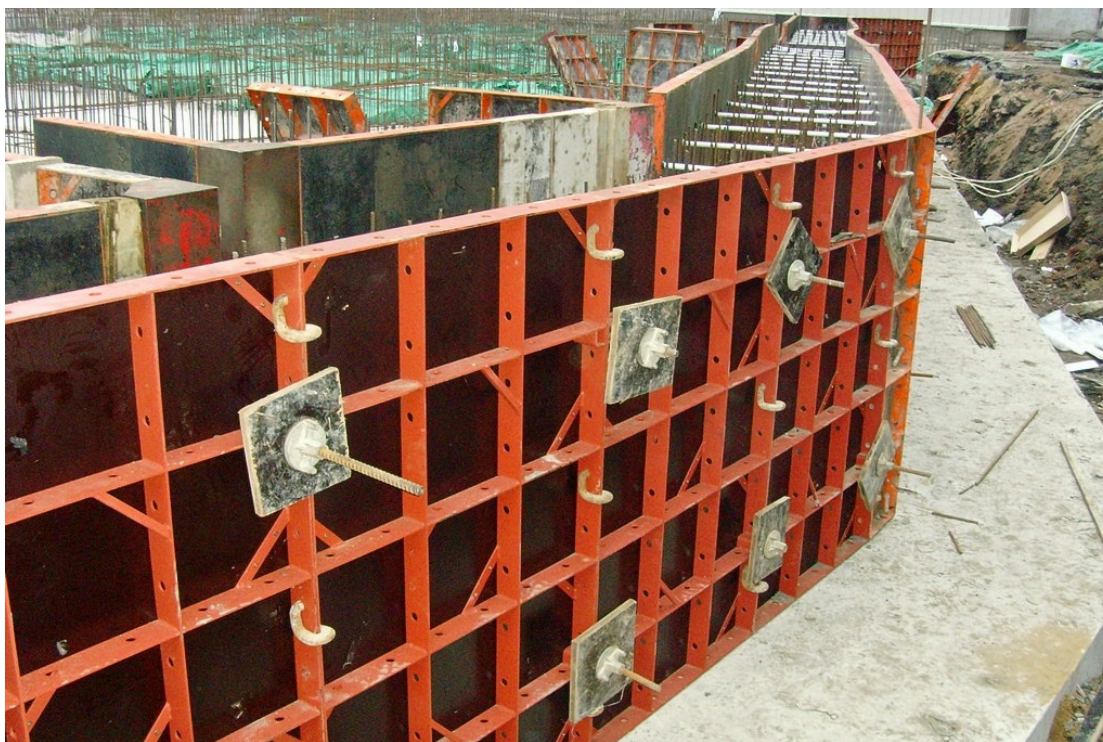
Рис. 1.10. Стержневые стяжки опалубки
