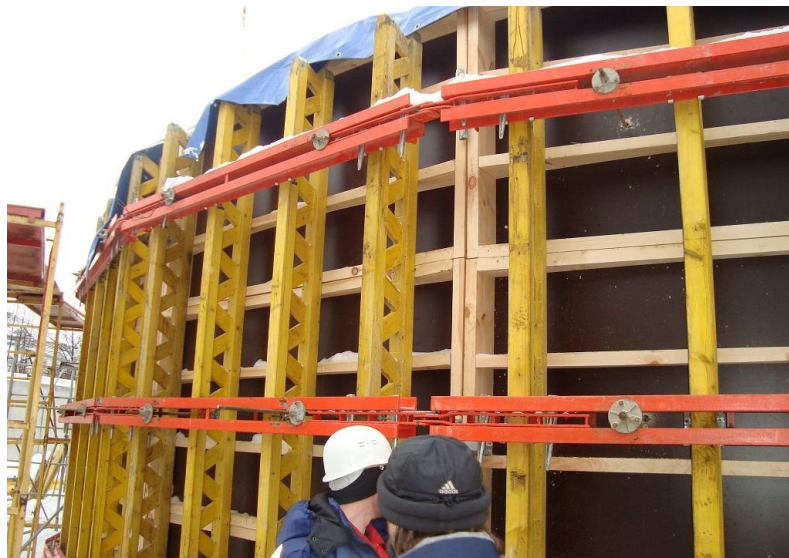
Рис. 1.16. Накладные балки, используемые в опалубочных системах
