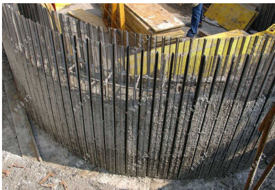
Рис. 1.47. Стальная несъемная перфорированная опалубка
