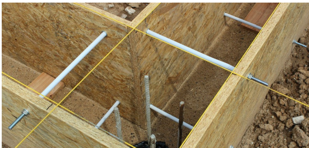
Рис. 1.12. Использование пластиковых трубчатых распорок при монтаже опалубки
