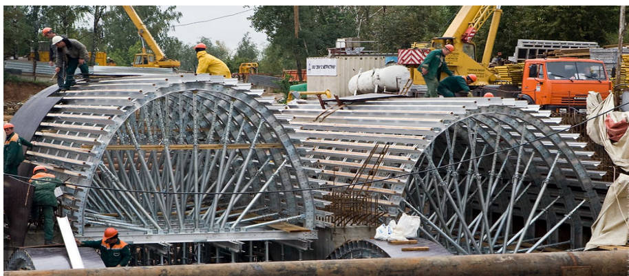
Рис. 1.24. Пример монтажа опалубки криволинейной поверхности
