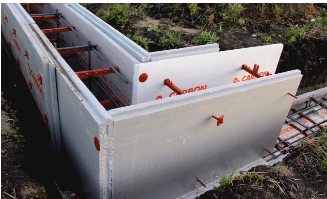
Рис. 1.49. Несъемная опалубка из экструдированного пенополистирола
