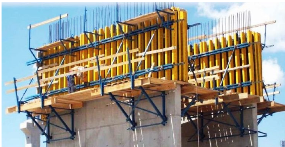
Рис. 1.17. Опалубочные подмости и леса
