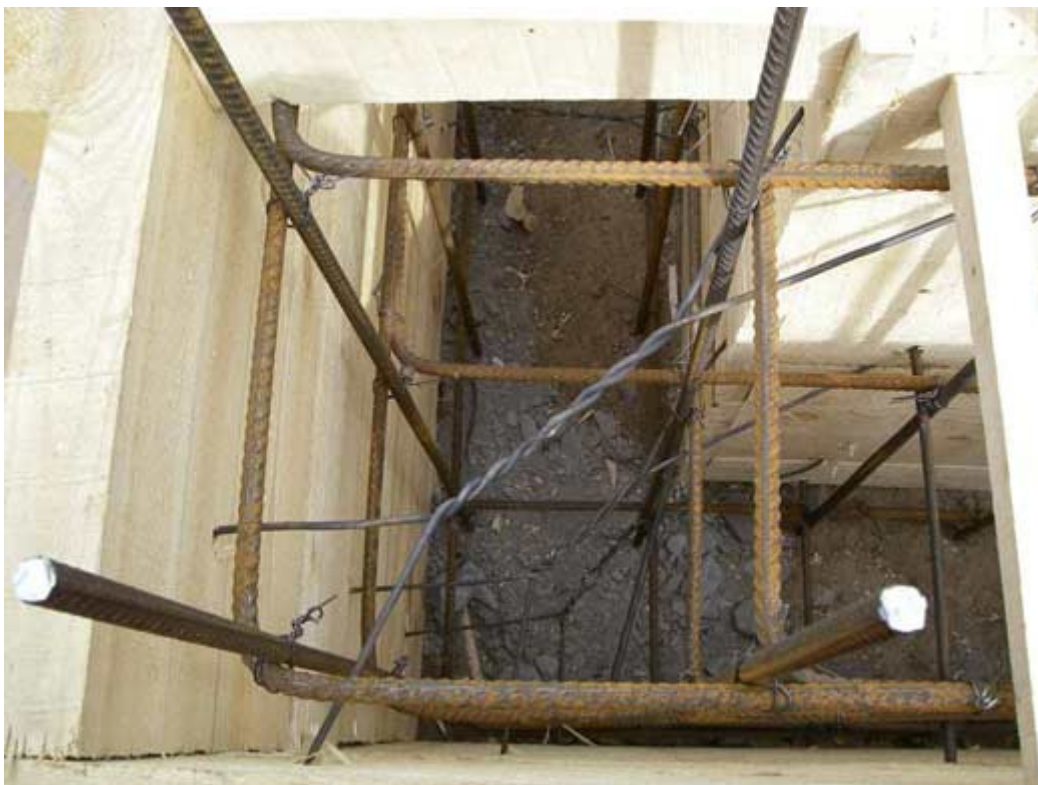
Рис. 1.9. Проволочная стяжка опалубки
