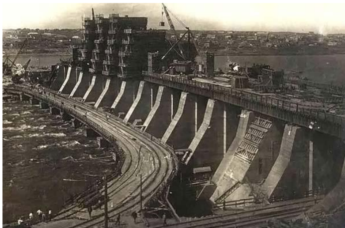
Рис. 1.3. Строительство Днепровской гидроэлектростанции
