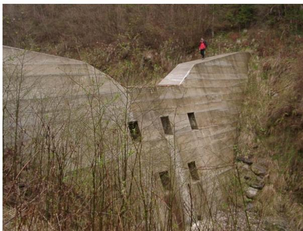
Рис. 3.4. Селепредотвращающая плотина со сбросными отверстиями в Австрии
