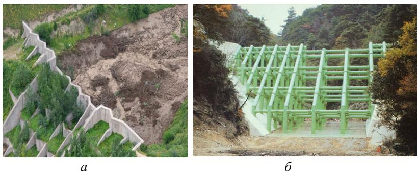
Рис. 3.1. Селезадерживающие плотины: *а* – глухого типа; *б* – сквозного типа
