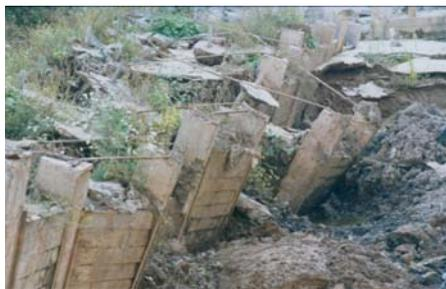
Рис. 3.59. Обрушение подпорной стенки
