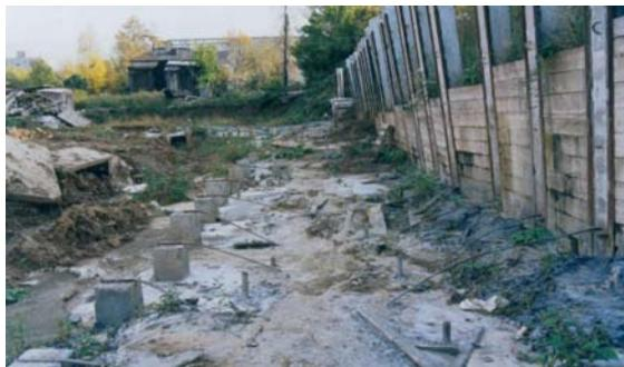
Рис. 3.58. Наклон свай внутреннего ряда подпорной стенки
