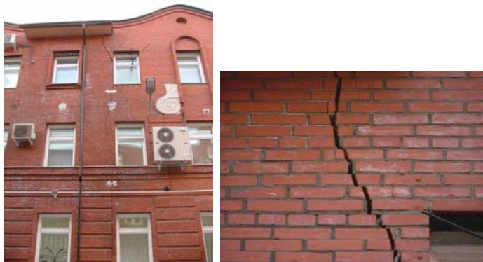
Рис. 2.3. Развитие вертикальных и наклонных трещин вследствие неравномерной осадки фундаментов
