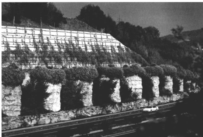
Рис. 3.5. Комбинированная анкерно-колодцевая стена для автомагистрали под крутым спуском: глубина колодцев – 40 м, глубина погружения в грунт – 27 м; начальная стадия озеленения спустя 2 года после окончания строительства
