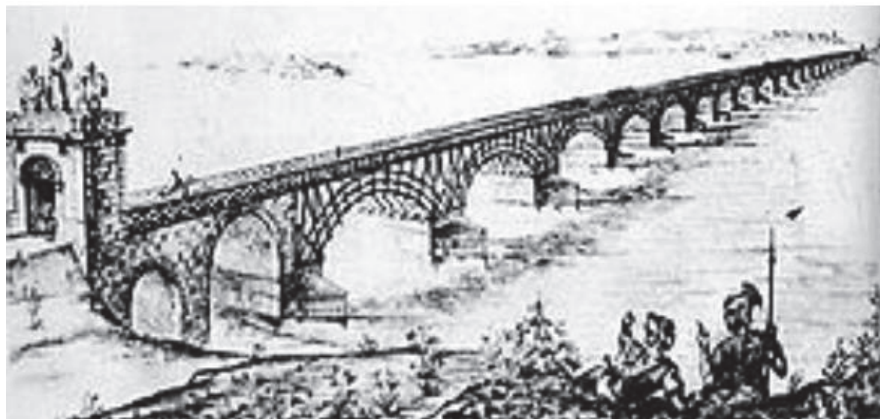
Мост Траяна через Дунай. Реконструкция
