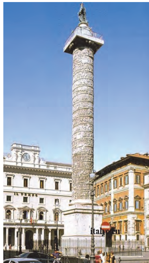
Колонна Марка Аврелия. Высота колонны составляет 29,6 м, ее пьедестала – 10 м
