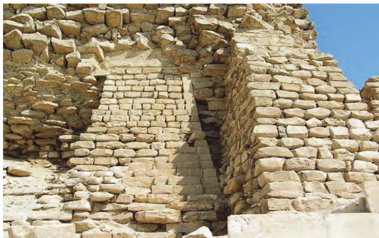
Структура внутренней кладки ступенчатой пирамиды
