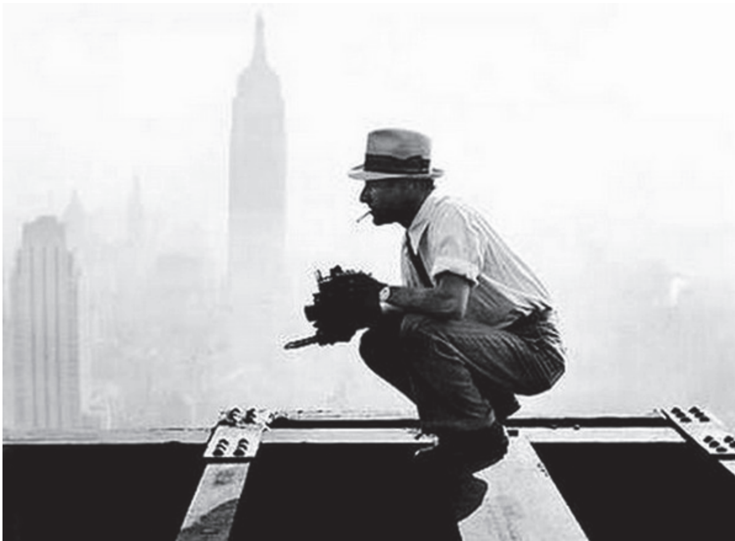
Фотограф Чарльз С. Эббетс, запечатлевший процесс монтажа металлических каркасов небоскребов в Нью-Йорке, 1932 год
