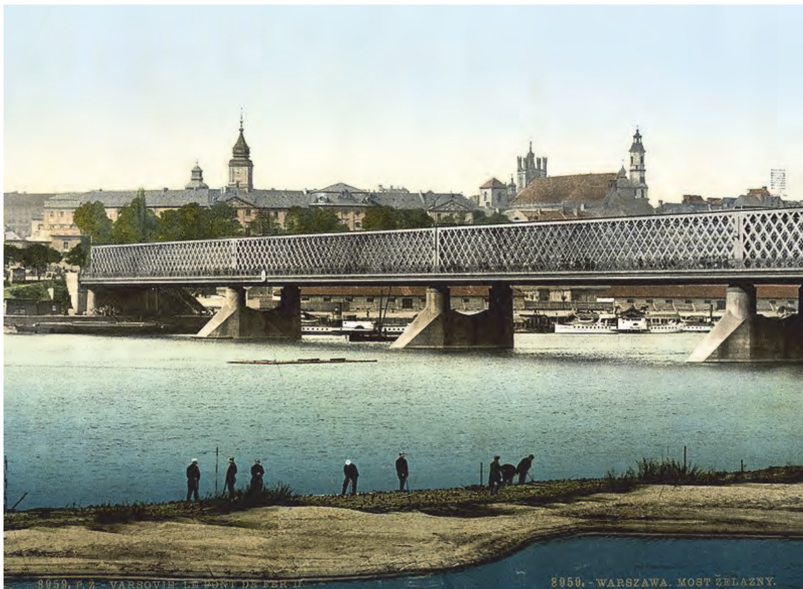
Мост С.В. Кербедза в Варшаве (Александровский мост). Взорван при отступлении русских войск из Варшавы в 1915 году
