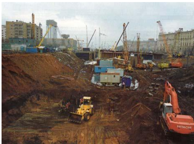
Рис. 3.12. Устройство котлована на месте существовавшего оврага
