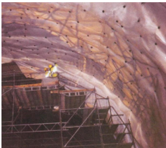
Рис. 5.10. Устройство гидроизоляции в тоннеле из полимерной мембраны
