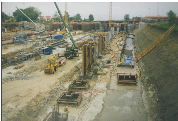
Рис. 3.9. Строительство тоннеля открытым способом в г. Копенгагене (Дания)
