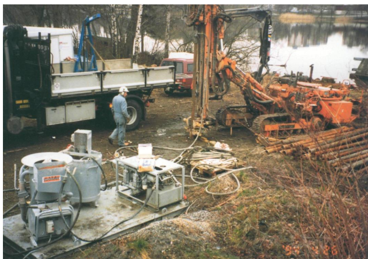
Рис. 4.41. Инъектирование грунтового массива методом цементации
