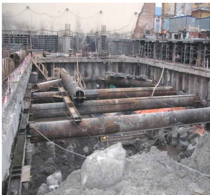
Рис. 3.67. Ограждение котлована с использованием металлических распорок
