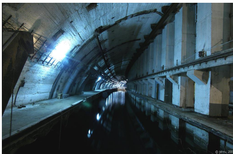
Рис. 3.33. Сухой док ремонтного завода подводных лодок
