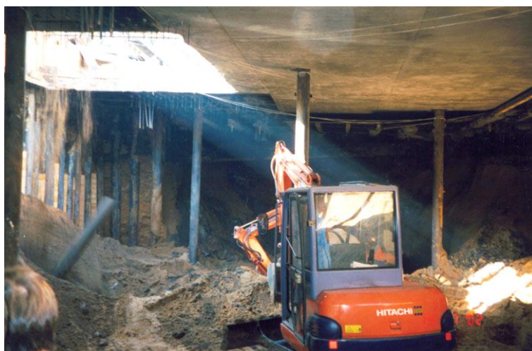
Рис. 4.26. Возведение здания методом сверху вниз
