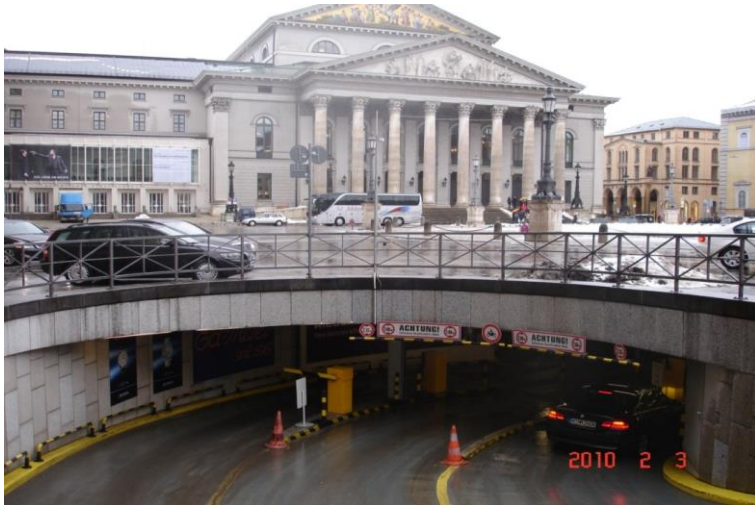
Рис. 3.5. Подземный паркинг под оперной площадью в г. Мюнхене
