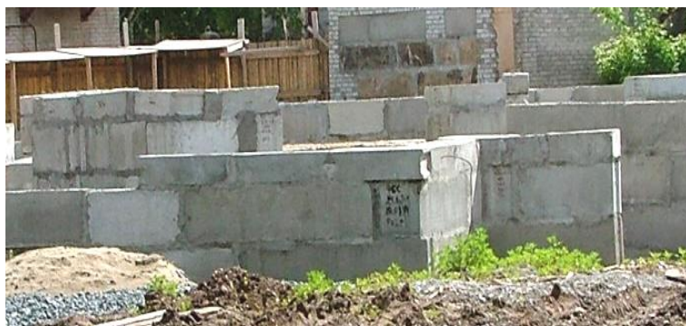
Рис. 4.50. Устройство стен подвалов из бетонных блоков
