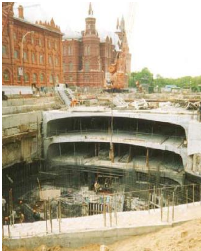
Рис. 3.23. Строительство подземной автостоянки на площади Революции в г. Москве
