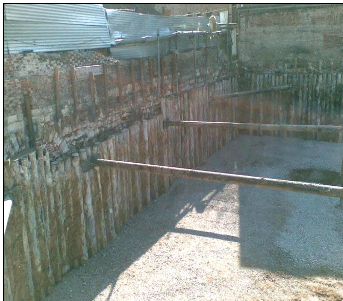
Рис. 3.69. Распорная система без распределительной балки
