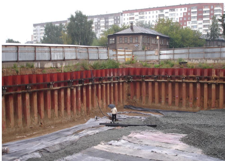
Рис. 3.75. Ограждение котлована из металлического шпунта
