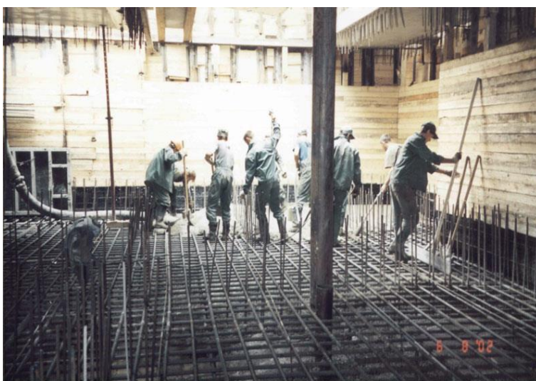
Рис. 4.30. Армирование плиты перекрытия
