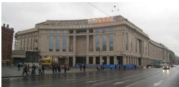
Рис. 3.3. Въездной пандус в подземный паркинг коммерческого комплекса «Галерея» на Лиговском проспекте в г. Санкт-Петербурге
