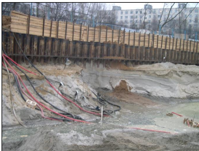
Рис. 2.1. Суффозия пригрузочной грунтовой бермы
