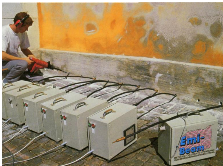
Рис. 5.7. Восстановление гидроизоляции наружной стены
