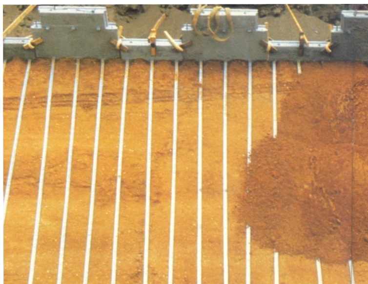
Рис. 4.65. Укладка стальных полос в тело подпорной стенки
