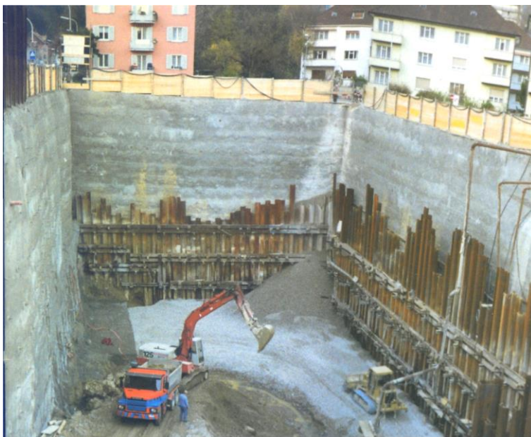
Рис. 4.1. Устройство глубокого котлована в г. Ессене (Германия)
