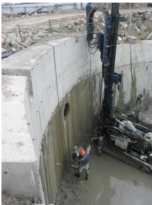
Рис. 2.4. Работы по усилению основания опускного колодца
