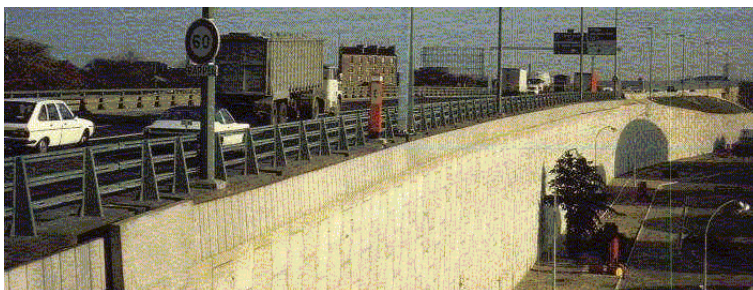
Рис. 4.66. Подпорная стенка из армированного грунта
