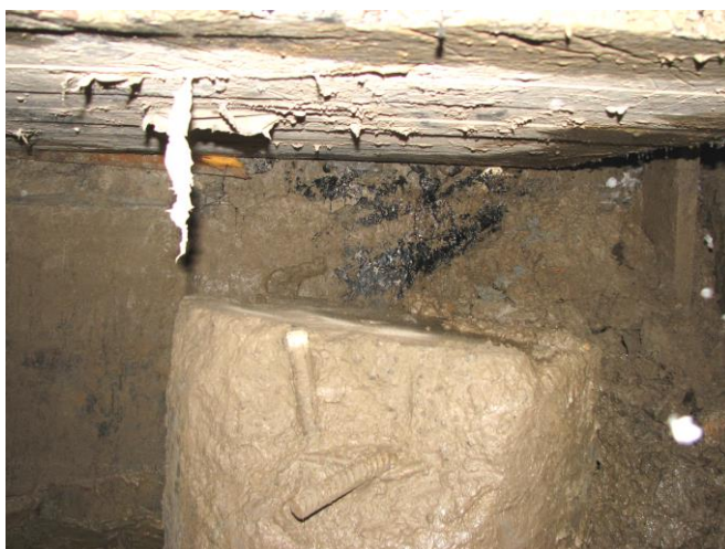
Рис. 2.3. Перемещение буронабивной сваи усиления обогнало осадку ростверка
