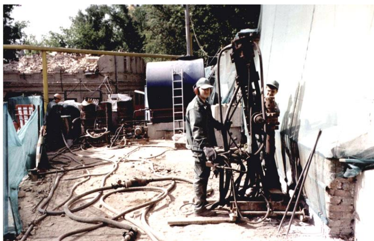
Рис. 4.28. Усиление существующих фундаментов
