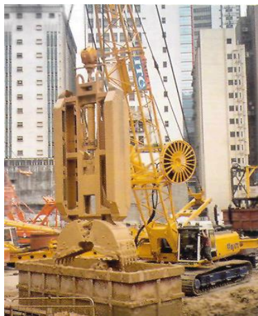
Рис. 4.15. Плоский двухчелюстной грейфер
