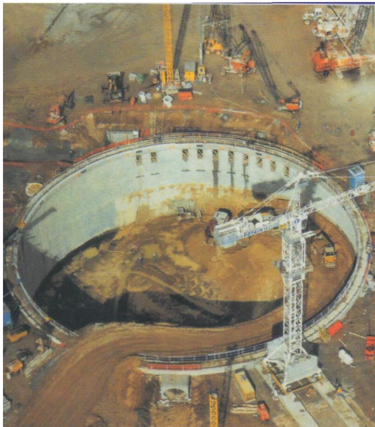
Рис. 4.3. Устройство опускного колодца в г. Льеж (Франция)
