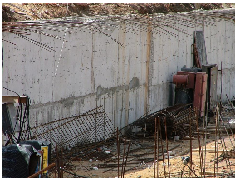
Рис. 4.54. Устройство монолитных стен подвалов
