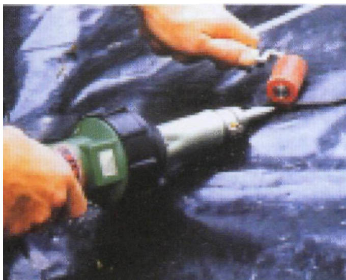
Рис. 5.11. Сварка полимерных листов гидроизоляции
