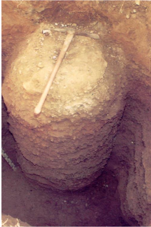
Рис. 4.56. Готовая свая (массив), полученная по технологии струйной цементации
