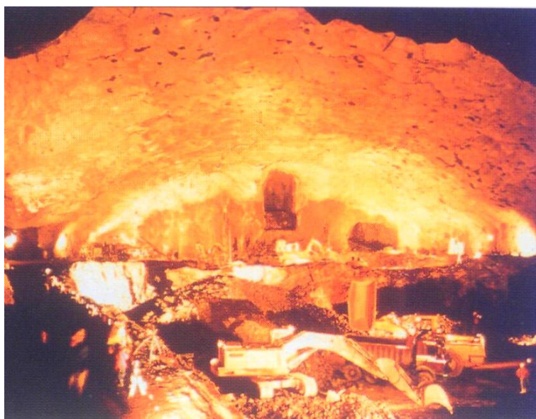
Рис. 3.26. Строительство ледового стадиона в г. Лилехамере (Норвегия)
