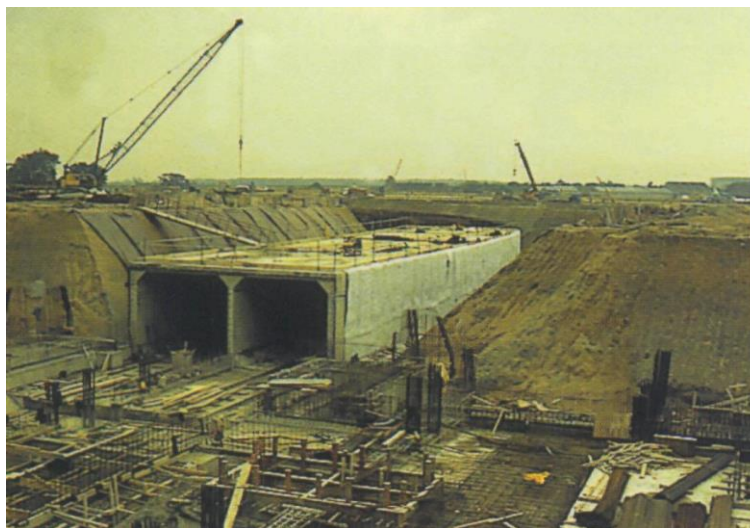
Рис. 3.10. Строительство тоннеля в аэропорту «Стенстед» г. Лондона (Великобритания)
