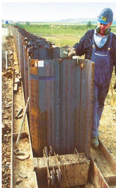
Рис. 3.79. Комбинированная система LARSSEN 430
