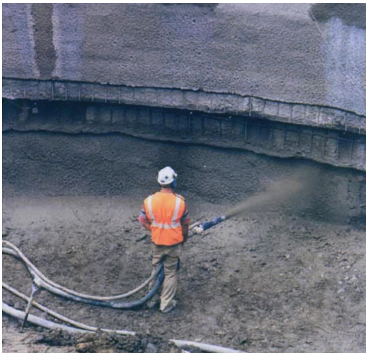
Рис. 5.9. Устройство гидроизоляции методом торкретирования
