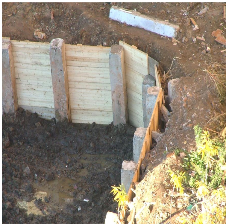
Рис. 3.66. Ограждение котлована из щитов по схеме «забирки»
