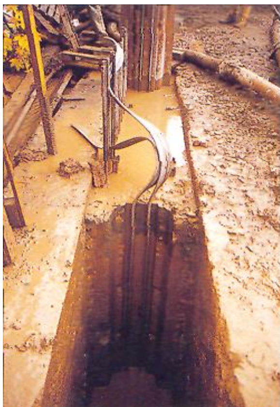
Рис. 4.18. Устройство захватки «стены в грунте»
