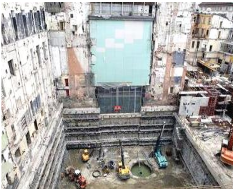
Рис. 3.62. Разработка котлована новой сцены театра «Ла Скала» в г. Милане (Италия)
