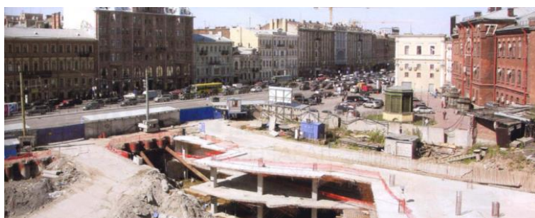
Рис. 3.4. Строительство подземного паркинга ТК «Галерея» на Лиговском проспекте в г. Санкт-Петербурге
