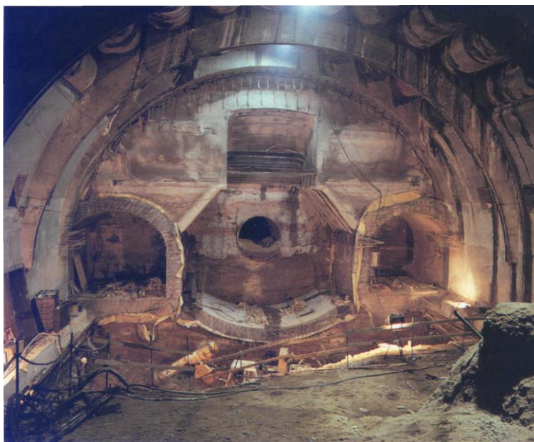
Рис. 4.32. Железнодорожный тоннель вокзала «Венеция» в г. Милане (Италия)
