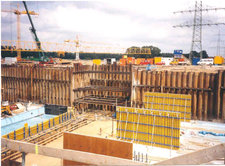
Рис. 3.80. Ограждение котлована из металлического шпунта при устройстве подземного сооружения
