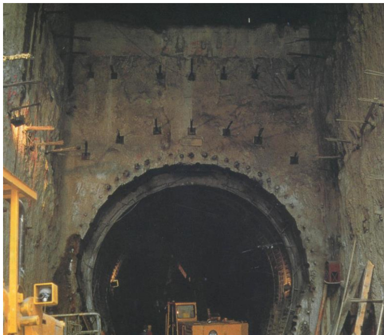
Рис. 4.48. Закрепление стенок тоннеля анкерными элементами «ТИТАН»
