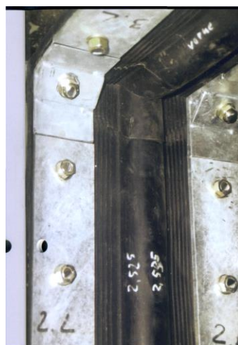
Рис. 5.14. Узел жесткого соединения гидроизоляции и конструкций
