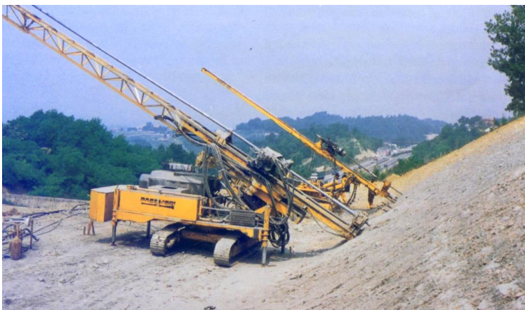
Рис. 4.42. Закрепление откосов насыпи автодороги Милан–Неаполь (Италия) посредством устройства грунтовых анкеров
