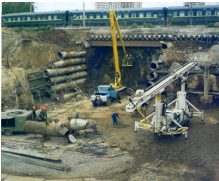
Рис. 4.33. Устройство автомобильного тоннеля на ул. Локомотивная в г. Перми методом продавливания
