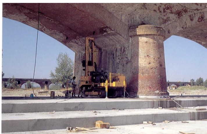
Рис. 4.61. Усиление фундаментов опоры моста Последний был построен в 1870 г. на деревянных сваях (рис. 4.62).
