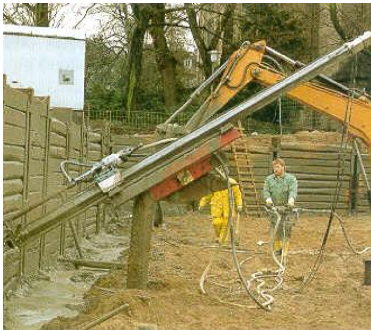
Рис. 3.73. Устройство грунтового анкера в ограждающей конструкции котлованов
