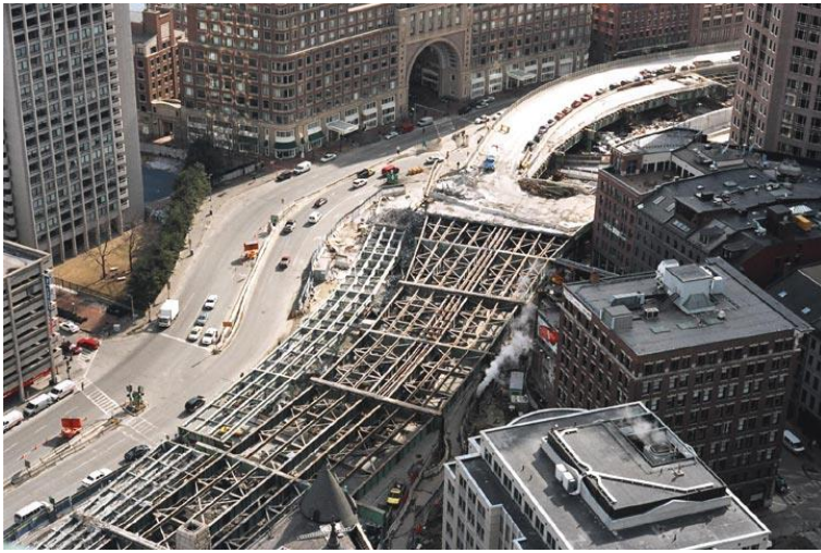
Рис. 3.16. Этап строительства Большого тоннеля в г. Бостоне (США)
