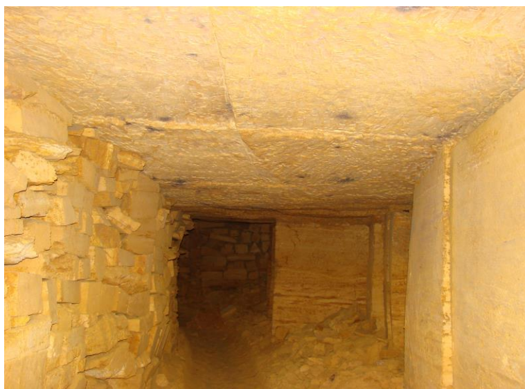
Рис. 7.5. Общий вид подземных выработок
