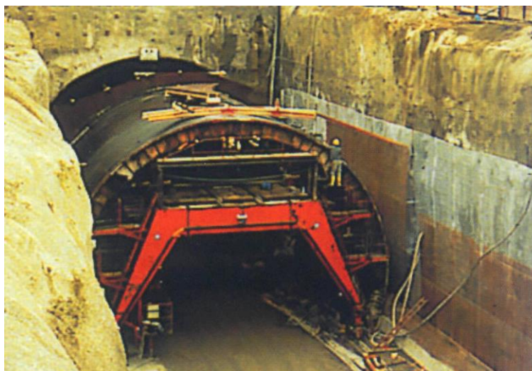
Рис. 4.74. Строительство туннеля Маркштейн в г. Штутгарте (Германия) методом щитовой проходки
