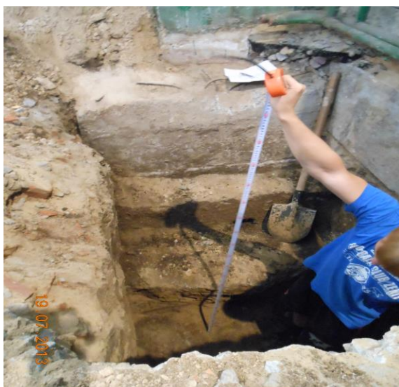
Рис. 2.5. Обмер фундамента в шурфе при инженерно-геологических обследованиях
