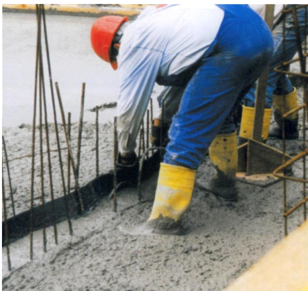
Рис. 5.16. Устройство выпусков гидроизоляции перед монтажом стен
