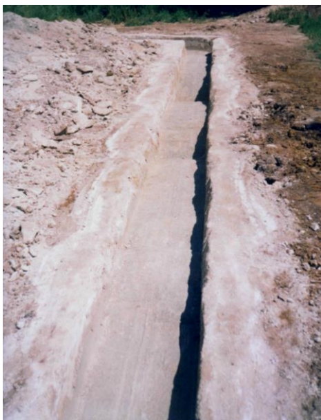
Рис. 5.17. Устройство противофильтрационной бентонитовой диафрагмы
