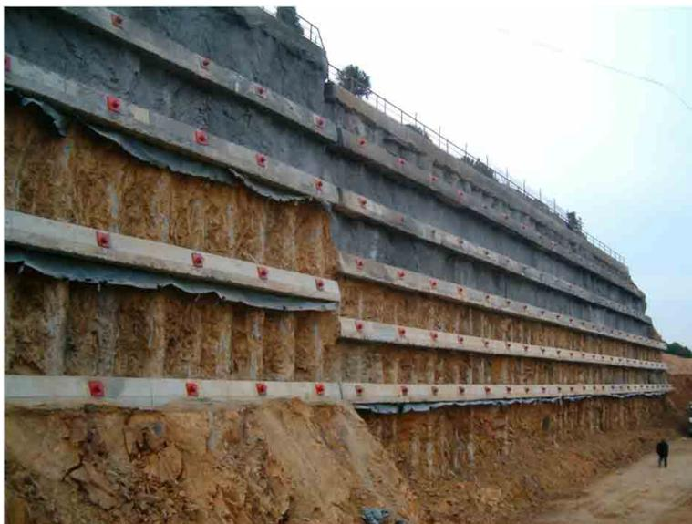
Рис. 36. Пример применения струйной технологии для устройства ограждения котлована (фото с сайта <http://zeminteknologijleri.com>)
