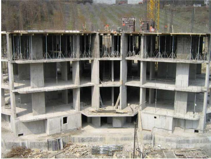
Рис. 16. Строящееся здание с монолитным каркасом
