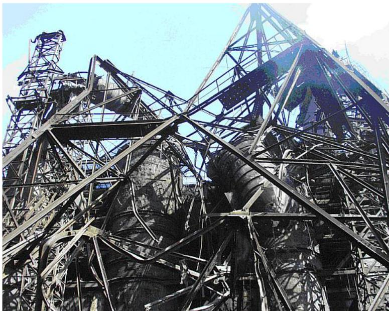
Рис. 7. Аварийное обрушение вытяжной башни в г. Магнитогорске (фото с сайта <http://www.pamag.ru>)
