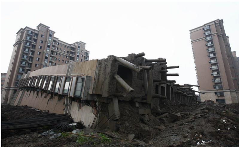
Рис. 6. Опрокидывание здания в Шанхае (фото с сайта <http://altfast.ru>)
