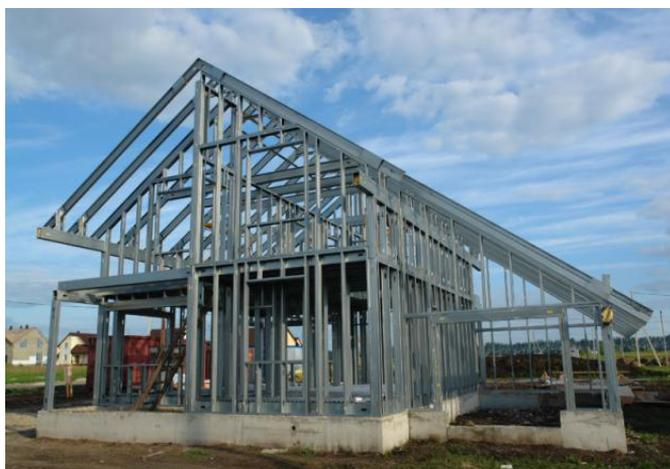
Рис. 18. Малоэтажный дом из легких стальных тонкостенных конструкций (фото с сайта smito.ru)
