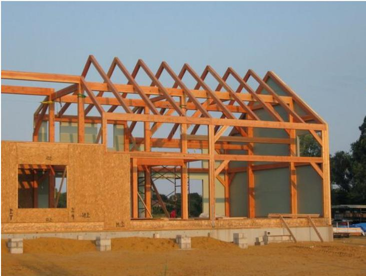
Рис. 17. Малоэтажный дом, построенный по каркасно-панельной технологии
