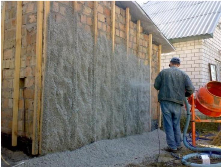
Рис. 21. Нанесение эковаты на ограждающие конструкции
