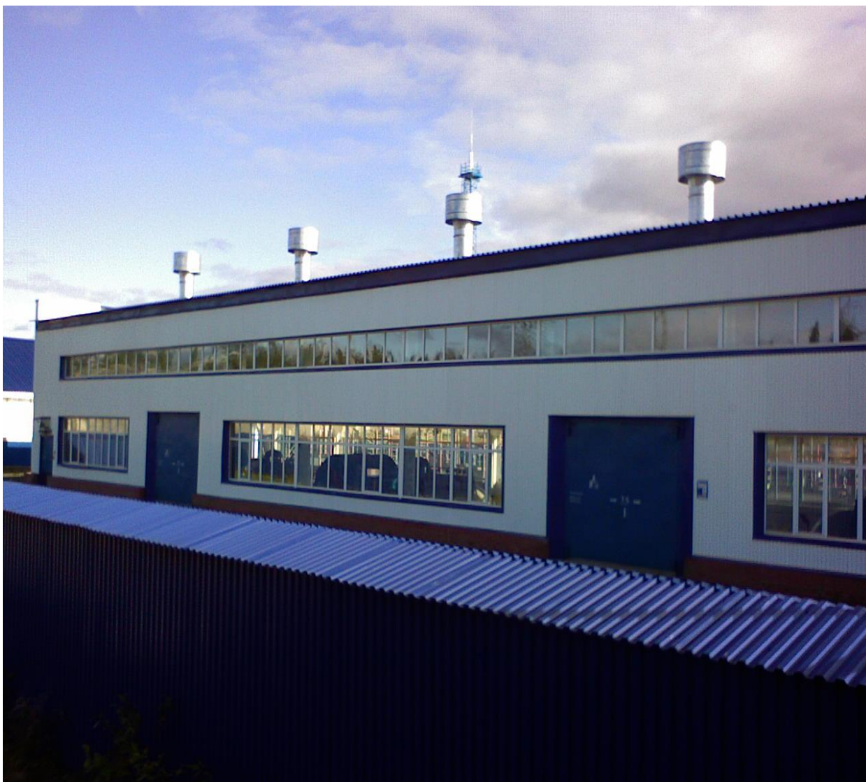
Рис. 1.8. Здание газокomppressorной станции
