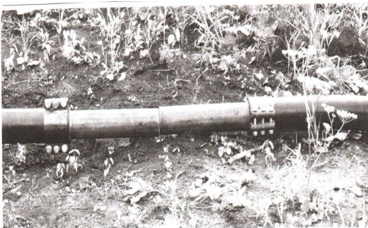
Рис. 7.5. Соединение стеклопластиковых труб хомутами
