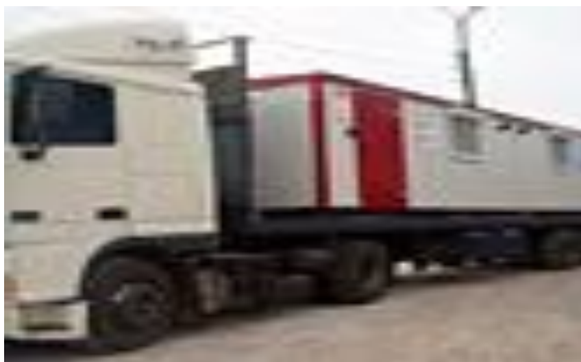
Рис. 11.1. Доставка насосного блока на строительную площадку
