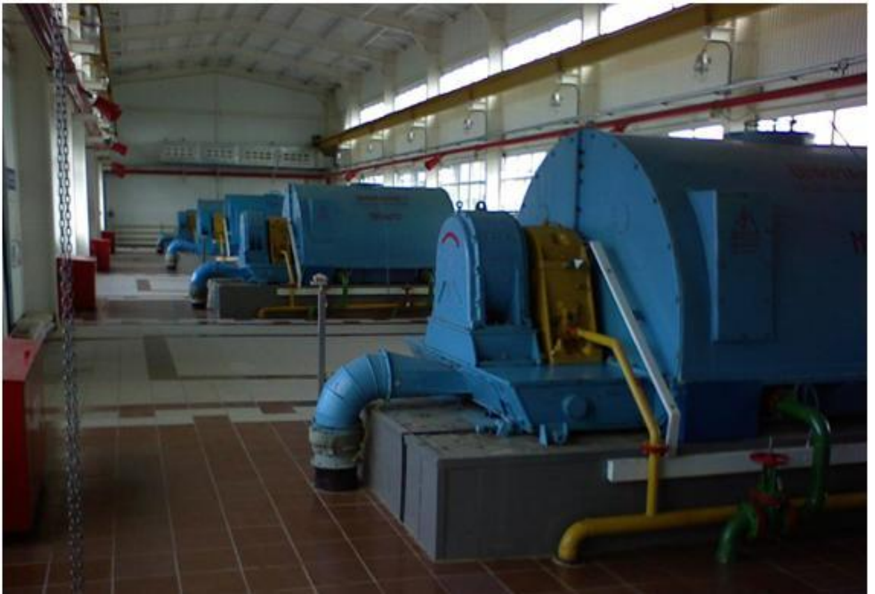
Рис. 5.7. Компрессор с электроприводом на монолитном фундаменте
