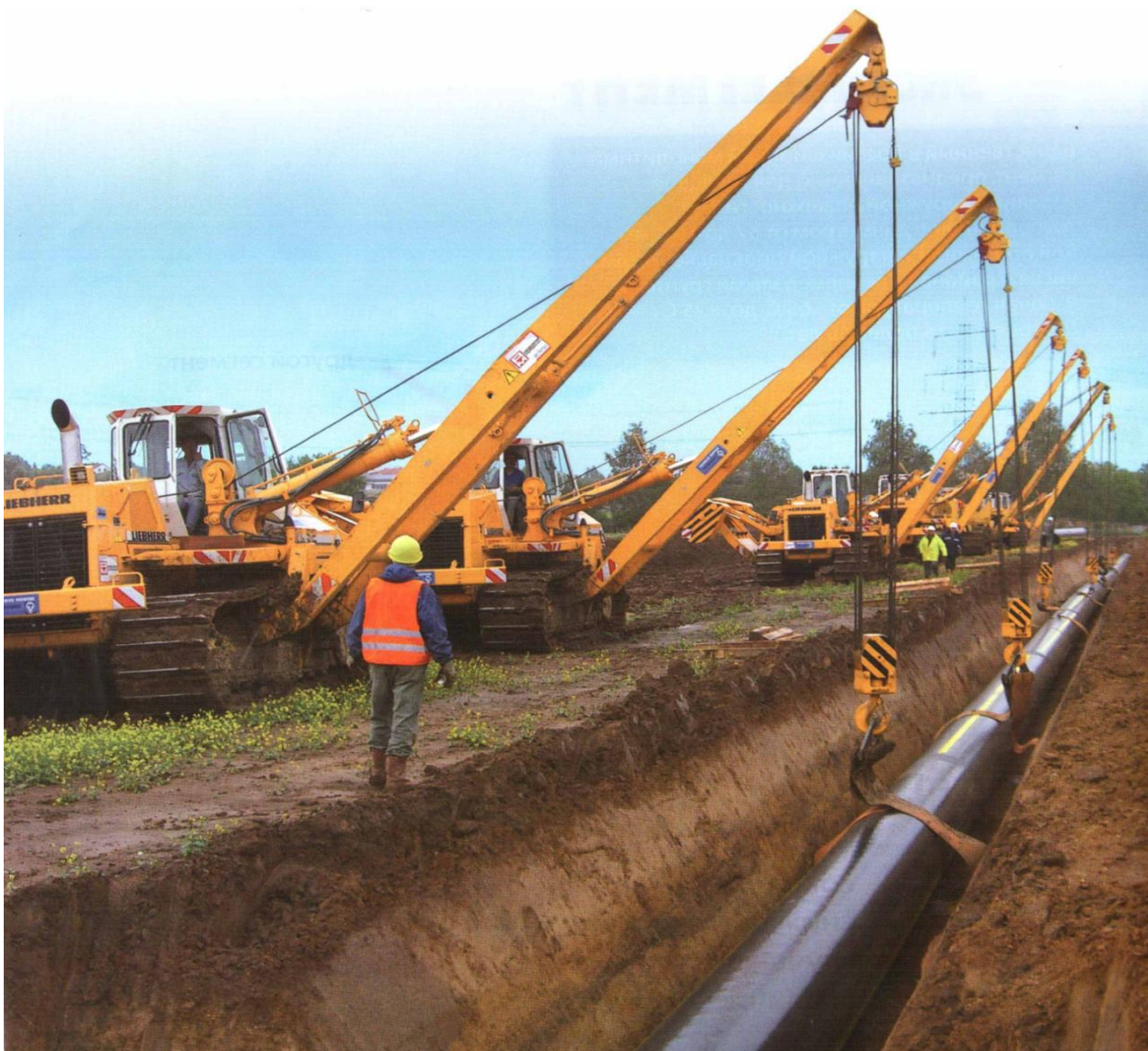
Рис. 14.3 Трубоукладчик Komatsu D 355 С
