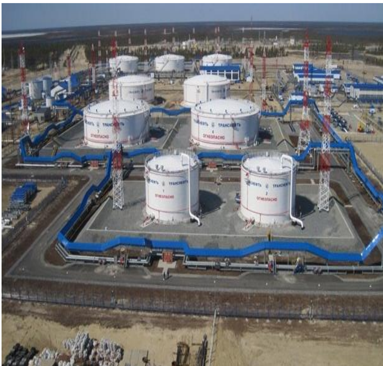
Рис. 1.11. Главные сооружения (центральный пункт сбора и подготовки нефти и газа)
