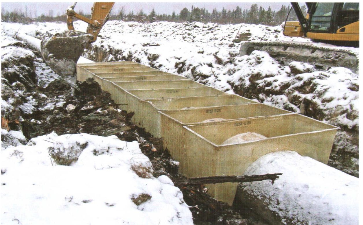
Рис. 8.2. Пригружение нефтепровода
