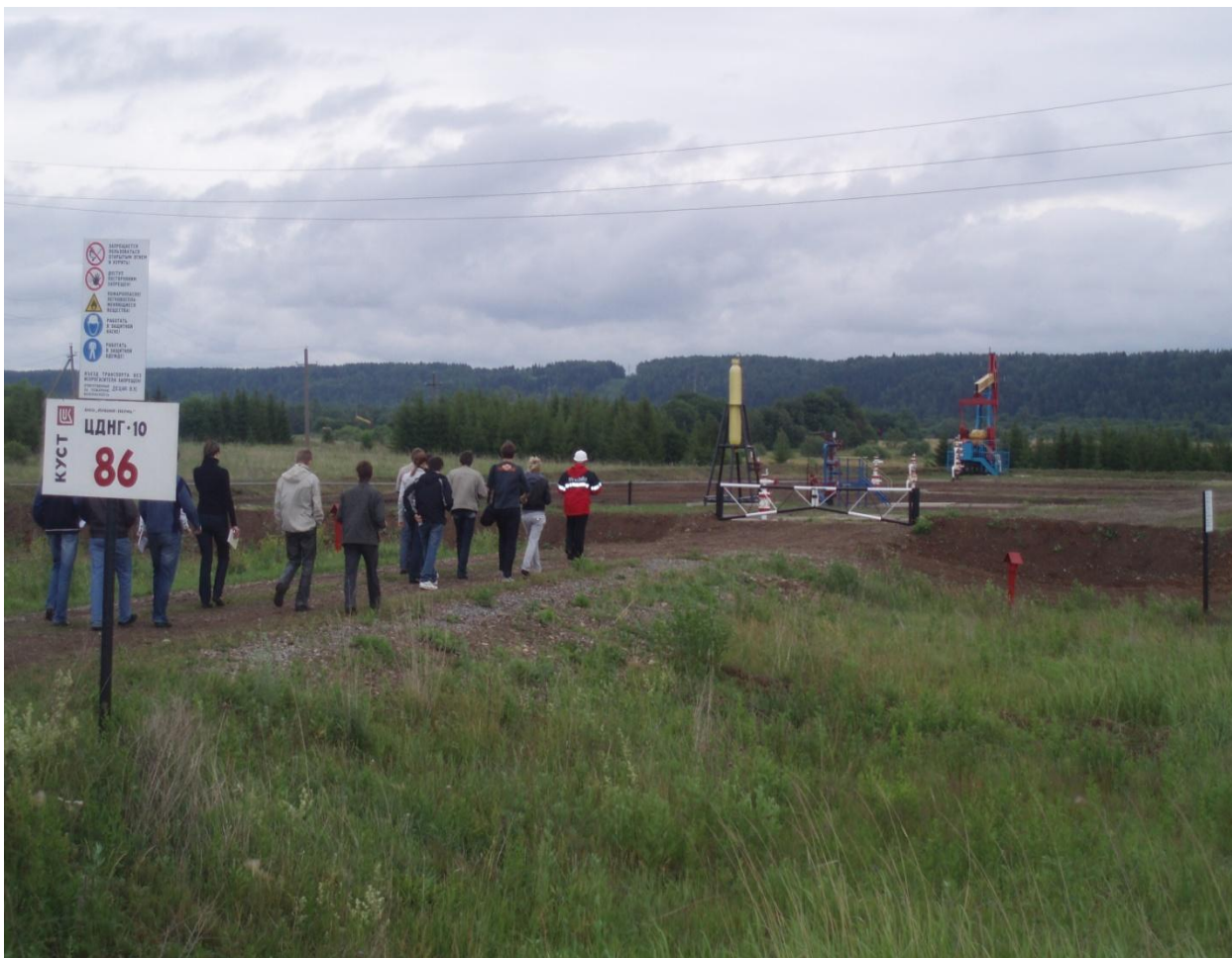
Рис. 1.3. Куст скважин. Станок – качалка, газовая, нагнетательная скважины
