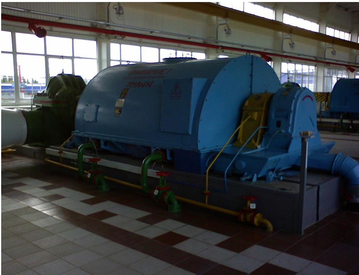
Рис. 6.6. Насосная внешней перекачки нефти с электроприводом
