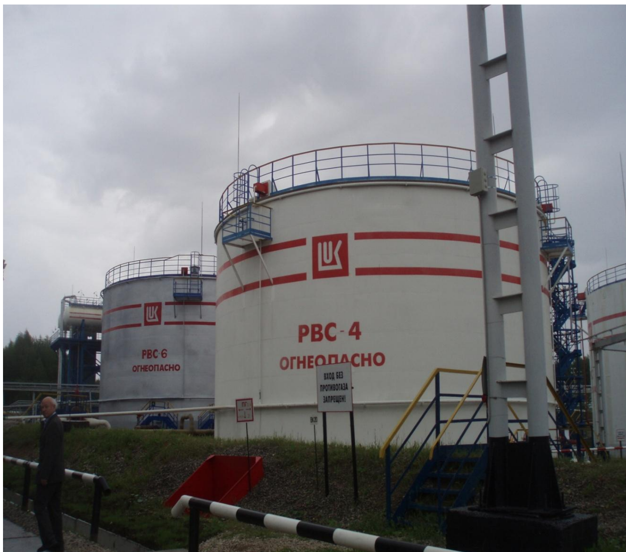
Рис. 6.3. Резервуары вертикальные стальные для хранения товарной и неподготовленной нефти
