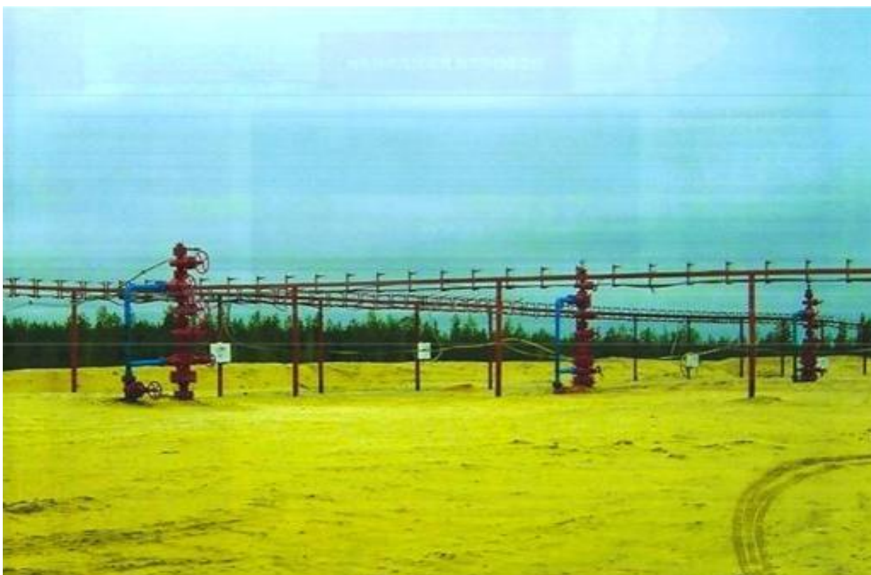
Рис. 5.3. Один из вариантов прокладки кабельных линий на кусте скважин
