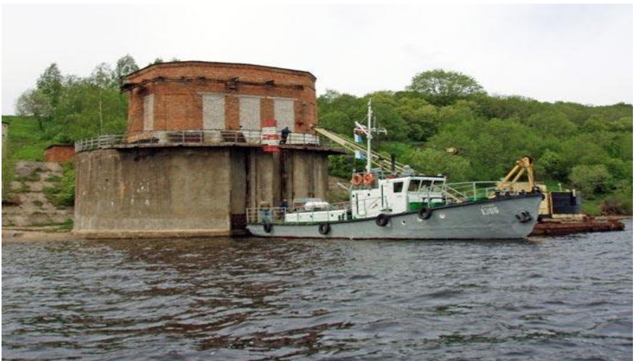
Рис. 1.13. Водозабор, первый подъем
