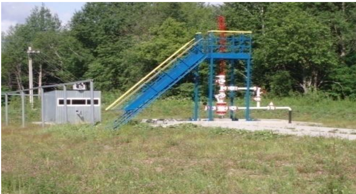
Рис. 1.1. Фонтанная скважина с депарафинизационной установкой
