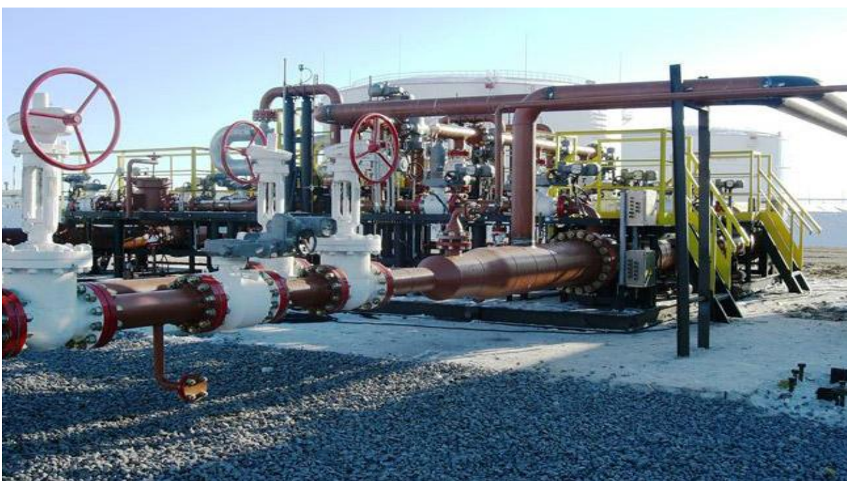
Рис . 6.7. Два варианта узлов учета товарной нефти
