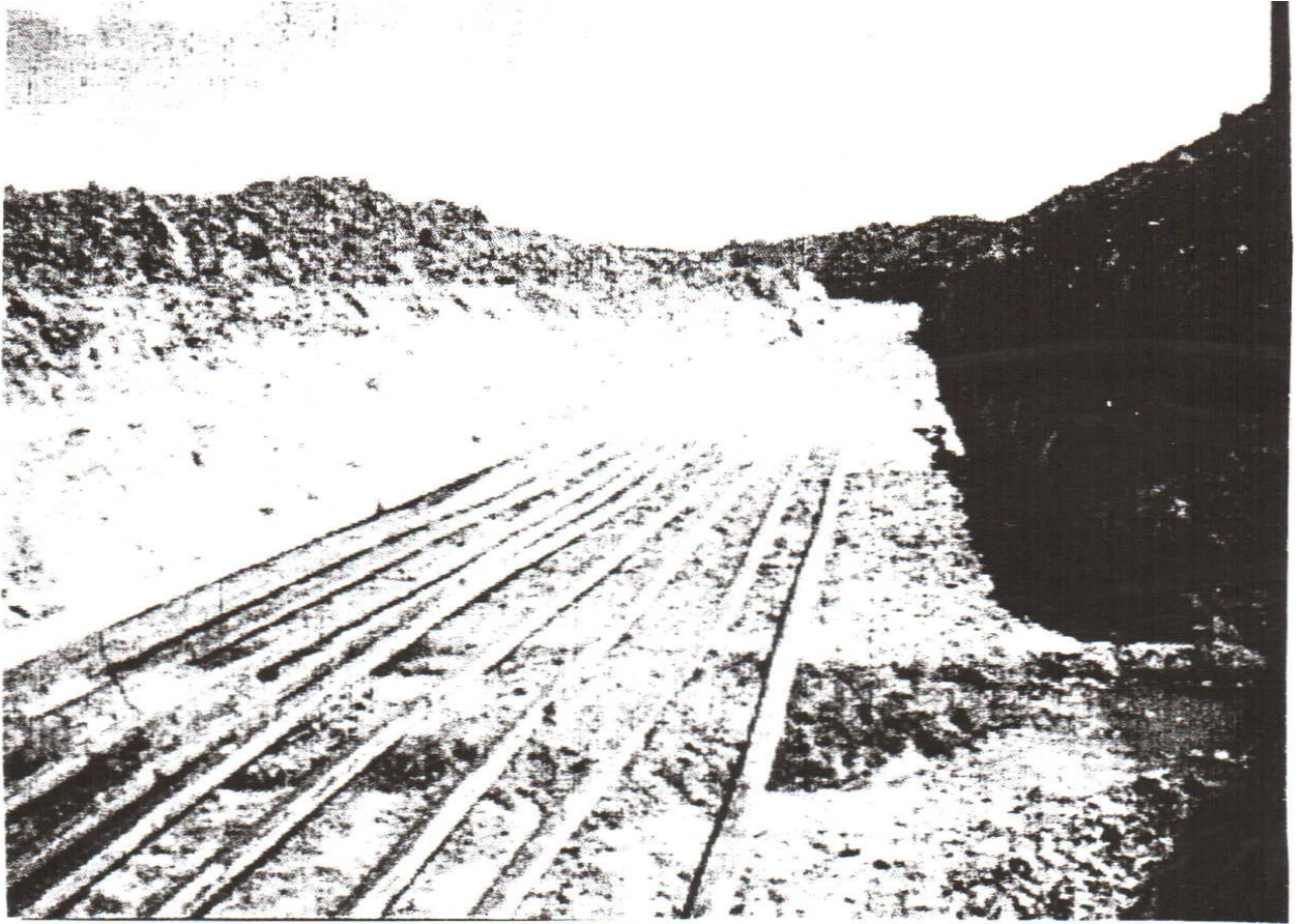
Рис. 8.1. Укладка нефтепроводов в одну траншею
