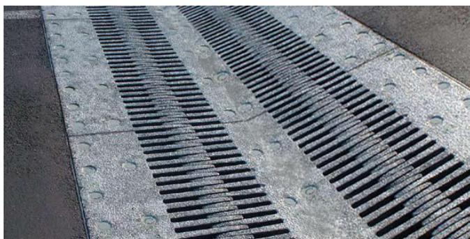
Рис. 4. ДШ с гребенчатой плитой с консольными двусторонне направленными пальцами
