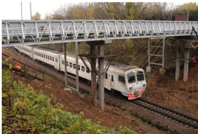
Рис. 2. Первый в России мост с цельнокомпозитными пролетными строениями (2004 г.)
