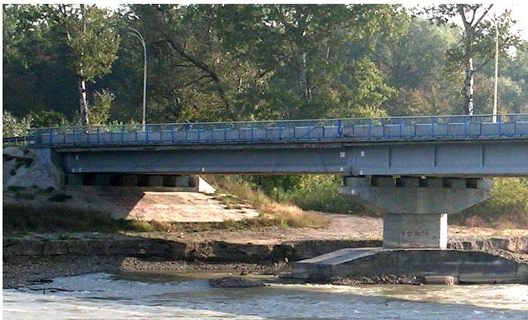
Рис. 6. Вид с левой (низовой) стороны от начала моста. Вид усиленной опоры № 5 и береговой опоры № 6. Размыв правого берега у основания конуса опоры № 6
