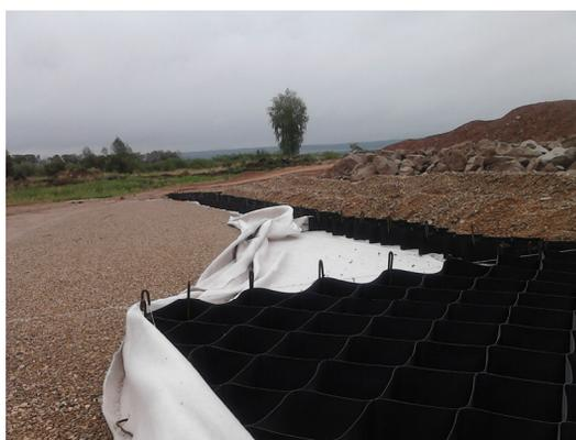
Рис. 2. Армирование верхнего слоя слабого основания геосотами с разделяющей прослойкой из иглопробивного материала и анкерровкой в подстилающем выравнивающем слое из ПГС
