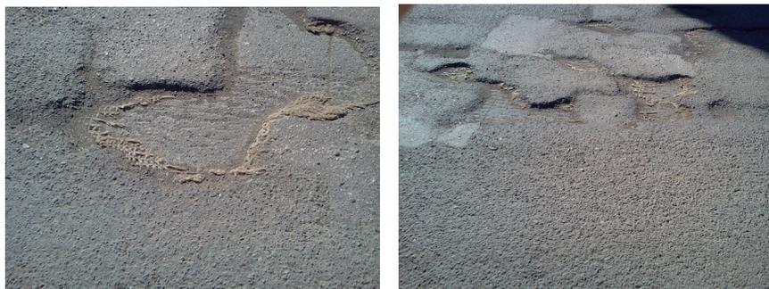
Рис. 1. Разрушение асфальтобетонного покрытия и армирующей геосетки из стекловолокна
