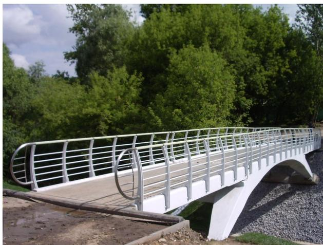
Рис. 4. Мост, изготовленный по технологии вакуумной инфузии
