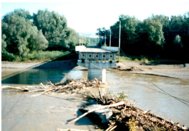
Рис. 1. Обрушение конструкций моста. Вид с левого берега
