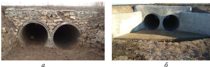
Рис. Общий вид двухочковой трубы: *а* – до мероприятий по устранению дефектов; *б* – после ремонта без устройства рисбермы (фото РосдорНИИ)
