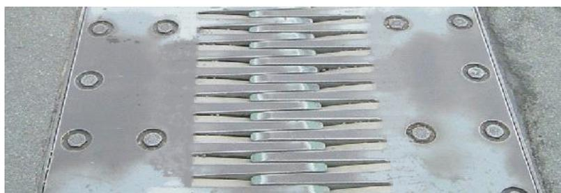
Рис. 10. Фрагмент секции гребенчатого ДШ, с упругими гребенчатыми пластинами (3D)
