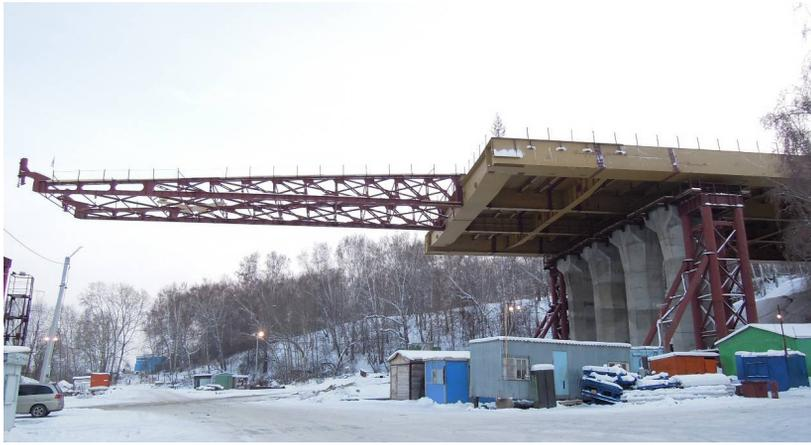
Рис. 2. Надвижка затяжки арочного пролетного строения моста через р. Обь в г. Новосибирске (по состоянию на 01.03.2012 г.)
